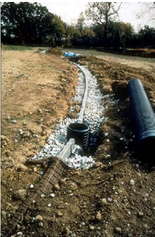
Level spreader Wikimedia Commons
