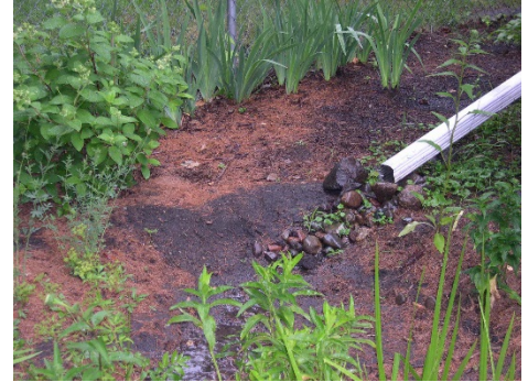
Down spout inlet to a rain garden Wikimedia Commons
