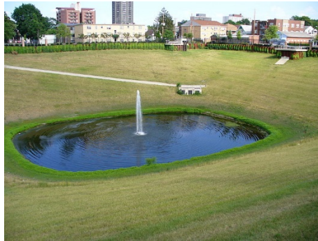
Wet detention pond, Illinois Wikimedia Commons
